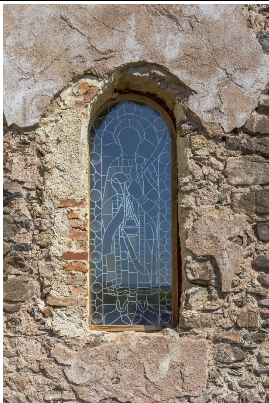
Čelní pohled na jižní okenní otvor presbytáře, které je rámováno odlišnou vyzdívkou po odstraněním starším ostění. Foto: Marta Pavlíková, 2020.
