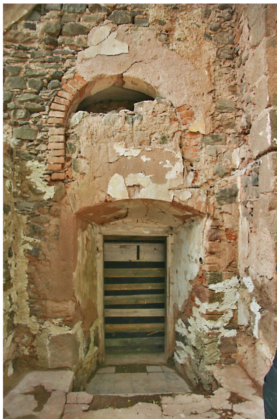
Jižní stěna sakristie se vstupním otvorem do presbytáře a nad ním se nacházejícím starším okenním otvorem. Foto: Hana Ptáčková, 2009.
