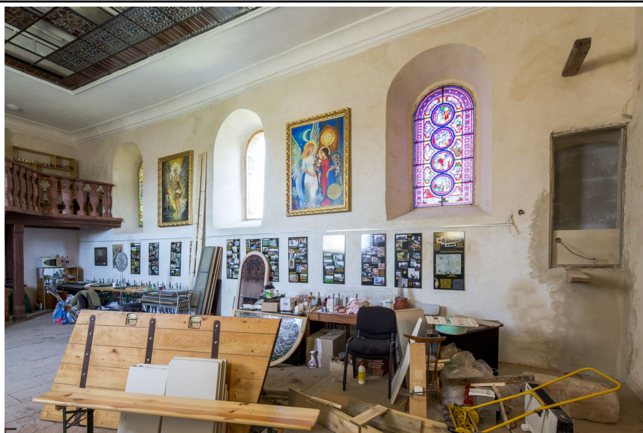
Severní strana lodi v pohledu od jihovýchodu.
