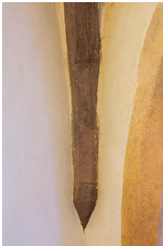
Jihozápadní výběh žebra klenby presbytáře v pohledu od severovýchodu. Foto: Marta Pavlíková, 2020.
