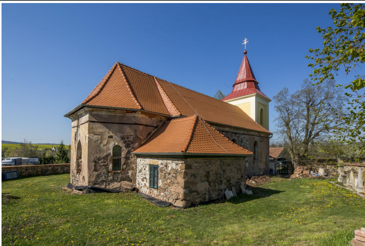
Celkový pohled od severovýchodu. Foto: Marta Pavlíková, 2020.
