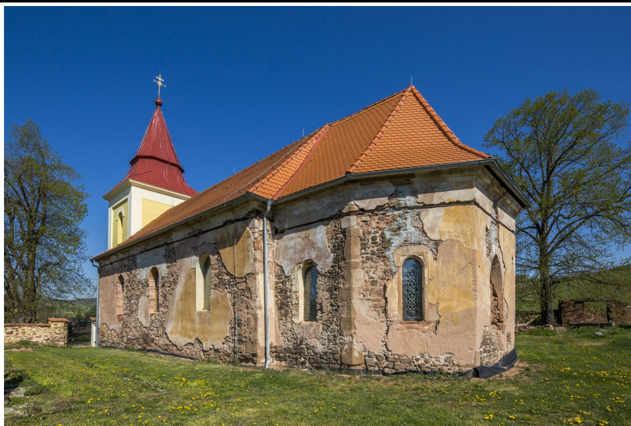
Celkový pohled od jihovýchodu. Foto: Marta Pavlíková, 2020.
