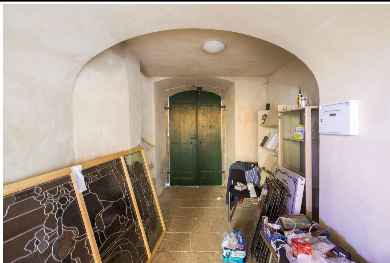
Přízemí věže v pohledu od východu. Foto: Marta Pavlíková, 2020.
