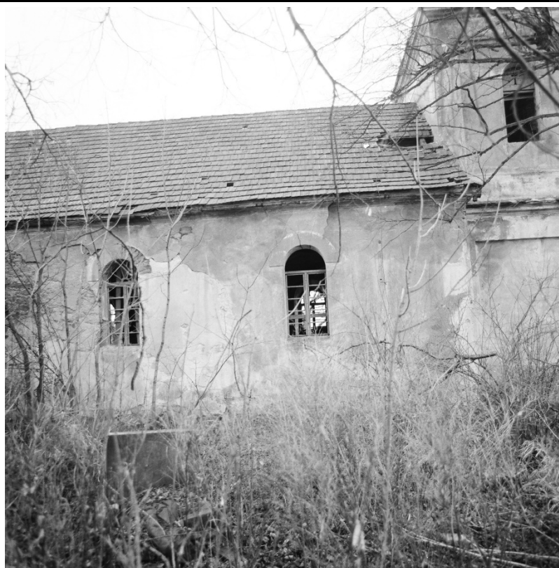
První dvě okenní osy od západu severní stěny lodi v pohledu od severu. Foto: 1988, sbírka negativů NPÚ ÚOP v Ústí n. L., sign. 95101.
