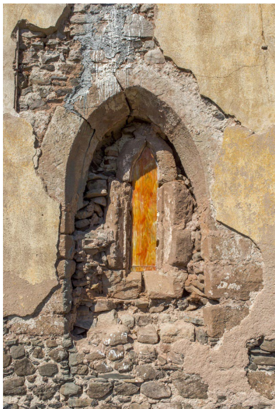
Čelní pohled na východní okenní otvor presbytáře s druhotně seskládaným a osazeným ostěním menšího gotického otvoru. Foto: Marta Pavlíková, 2020.
