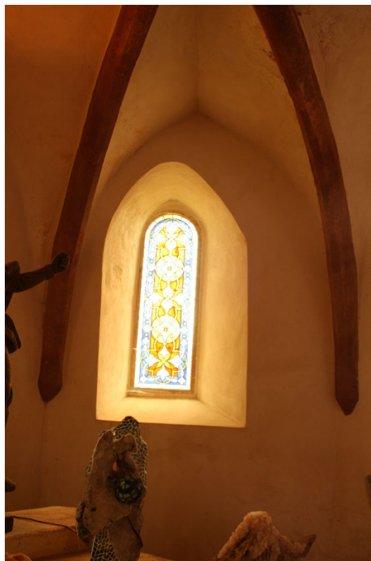
Čelní pohled na jihovýchodní okenní otvor presbytáře. Foto: Jaroslav Skopec, 2015.
