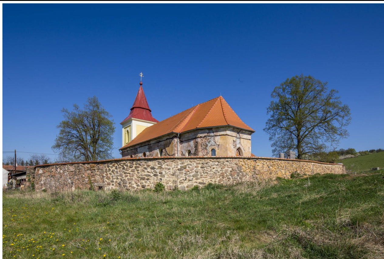
Celkový pohled od jihovýchodu. Foto: Marta Pavlíková, 2020.
