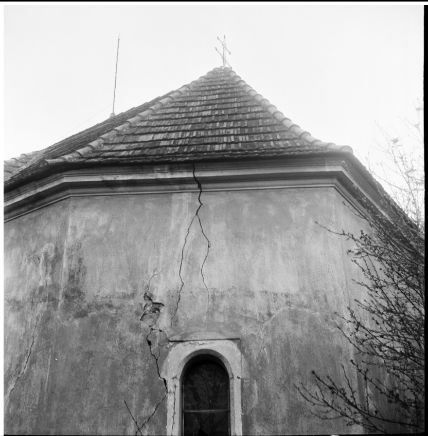
Čelní pohled na jihovýchodní stěnu presbytáře. Foto: 1973, sbírka negativů NPÚ ÚOP v Ústí n. L., sign. 49253.
