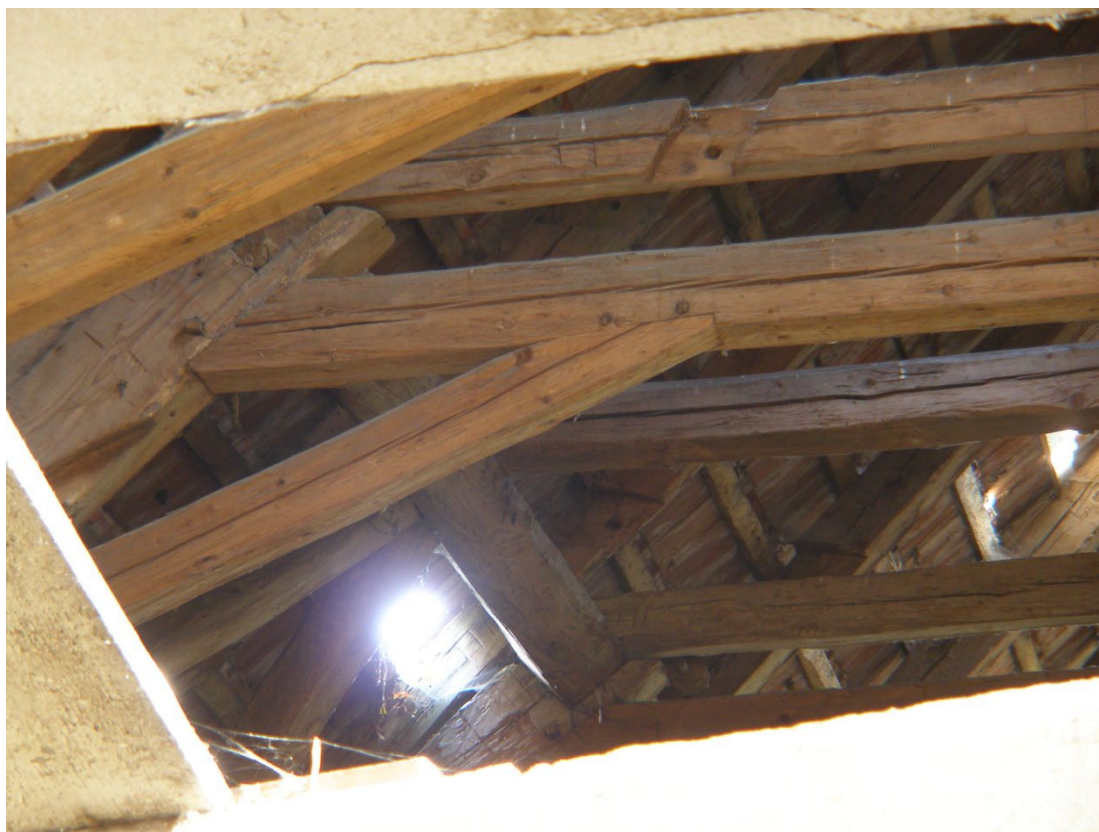
Krovová konstrukce střechy lodi. Foto: Jan Koloc, 2006.
