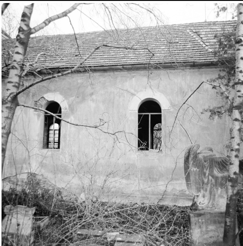
První dvě okenní osy od východu jižní stěny lodi v pohledu od jihu. Foto: 1988, sbírka negativů NPÚ ÚOP v Ústí n. L., sign. 95102.
