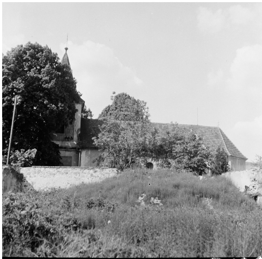
Celkový pohled od jihu. Foto: 1963, sbírka negativů NPÚ ÚOP v Ústí n. L., sign. 9138.
