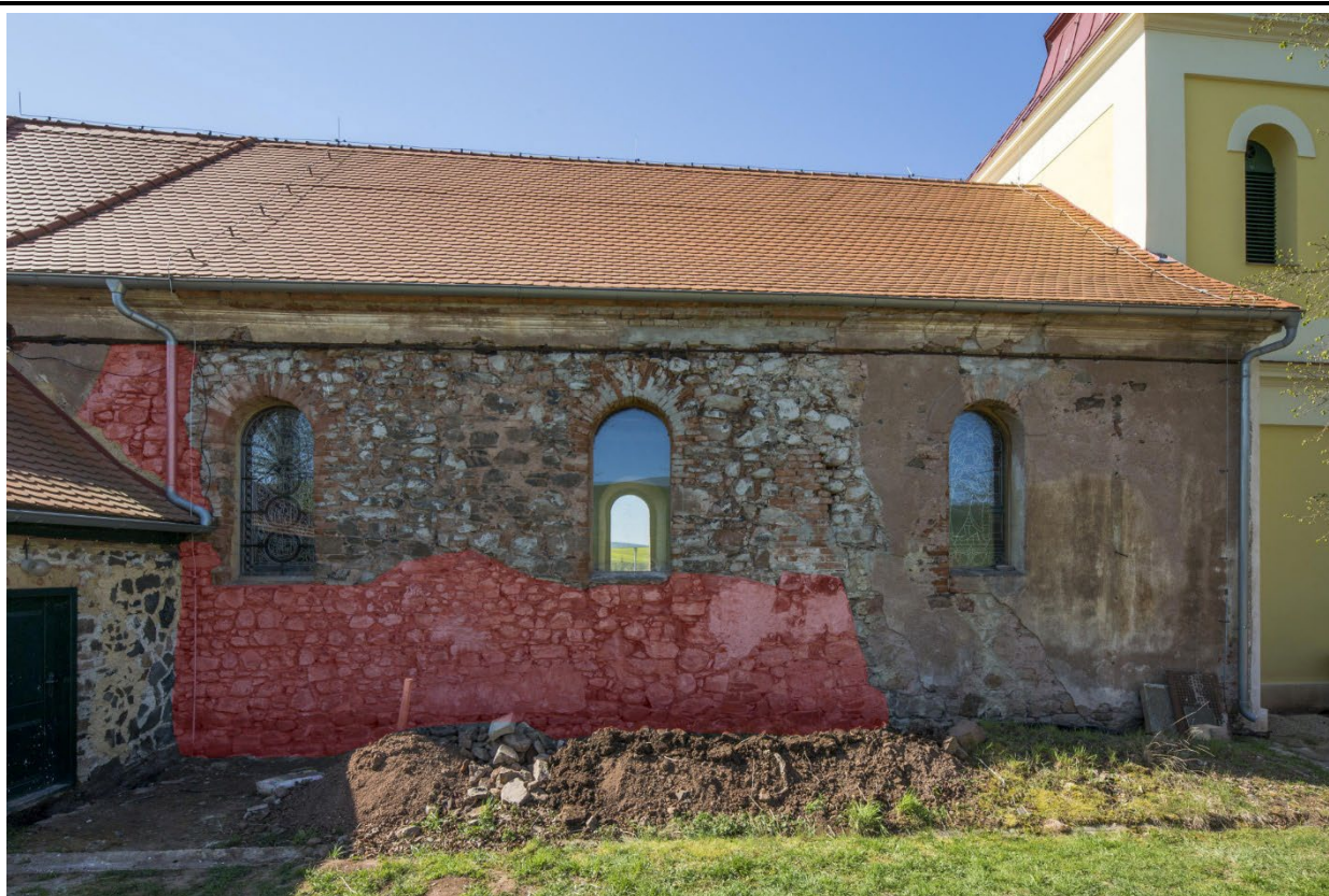
Čelní pohled na severní průčelí lodi s vyznačenou plochou se zachovaným středověkým zdivem. Foto: Marta Pavlíková, 2020.
